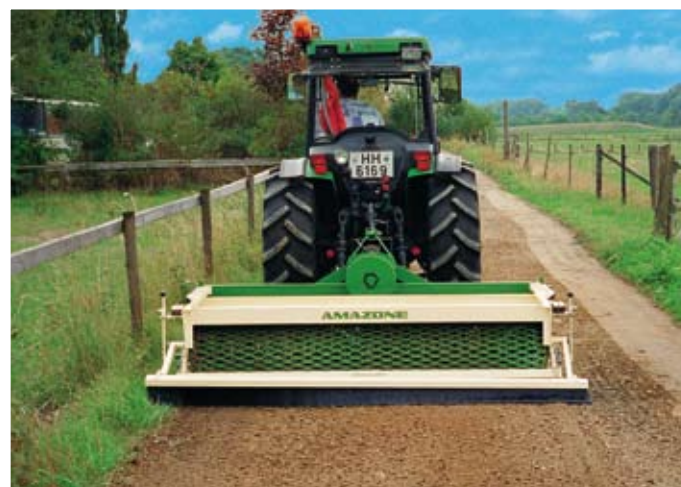
Renovatie van wandelpaden en gelijktijdige mechanische onkruidbestrijding met de onderhoudscombinatie voor verharde velden.
